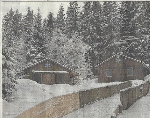
Die Vereinshütten der Schierker Rennrodler sind in Eigenleistung repariert worden.
